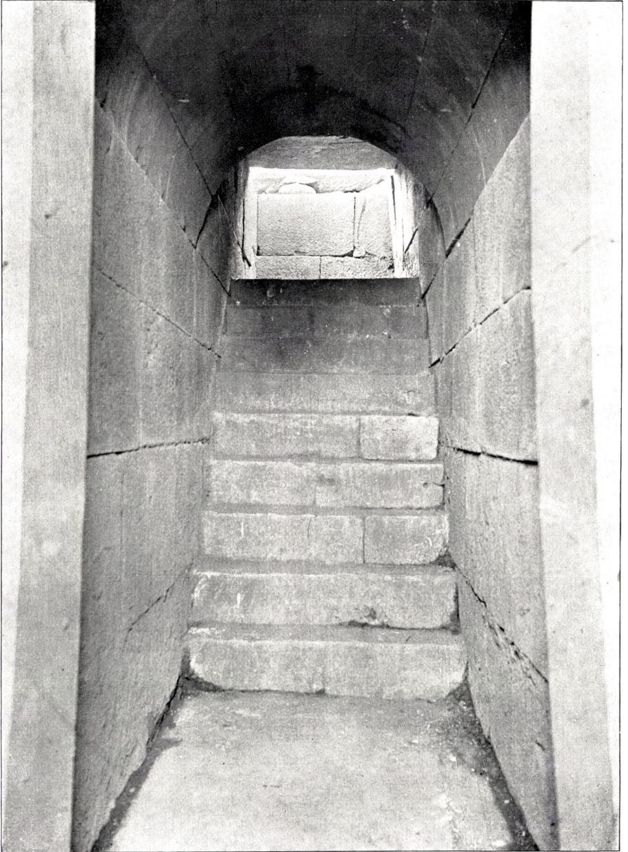
Fig. 117. Plattform und Treppe des hellenistischen Grabes.
