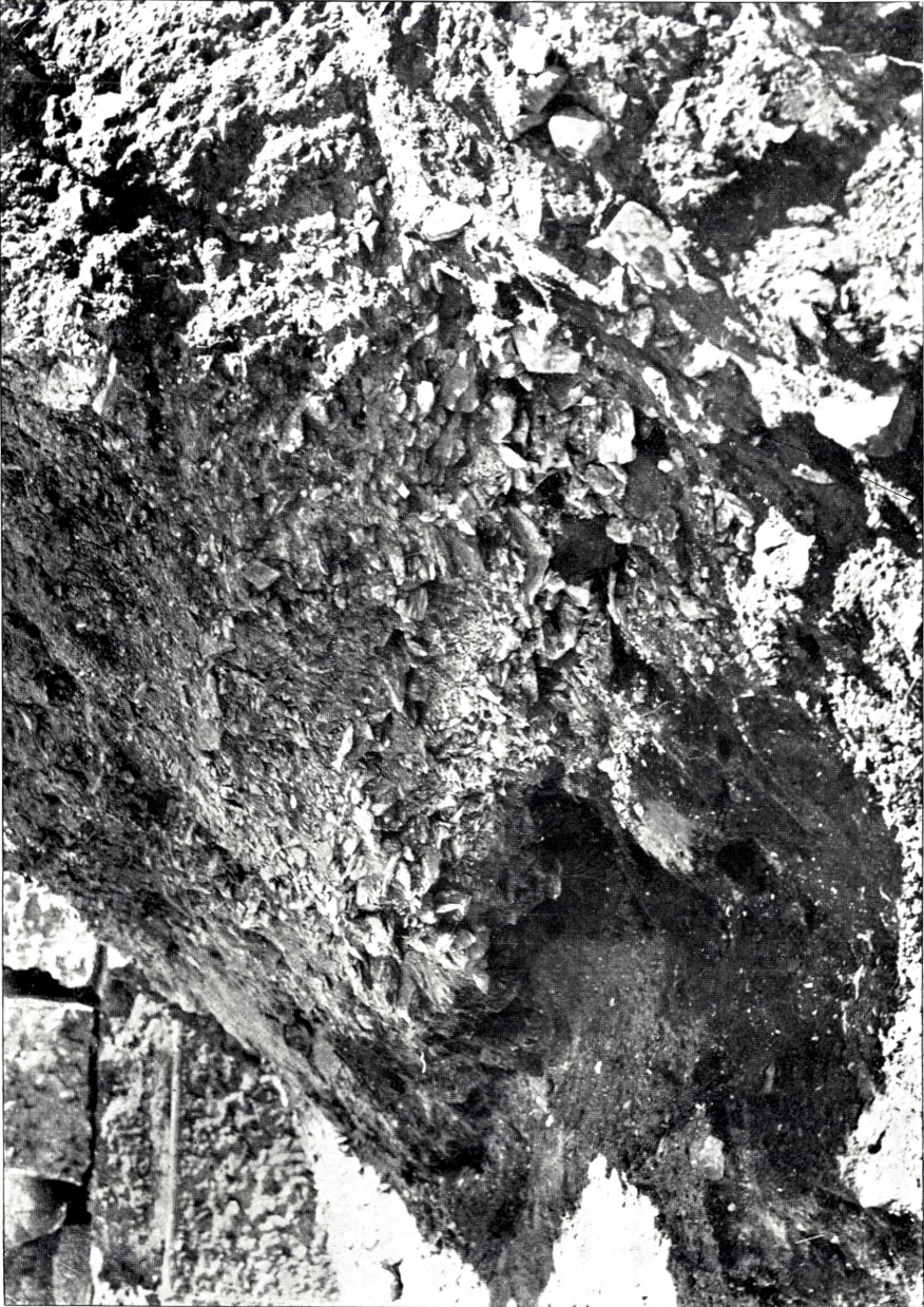
Fig. 12. Steinsplinter neben der Terrassenmauer.
